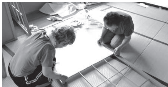
シルバーバンクにて障子張り替え作業
